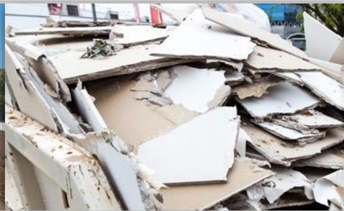
Déchets de plâtre
